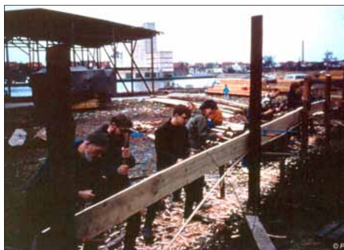
En af de lange bordgange hugges med skarøkser
