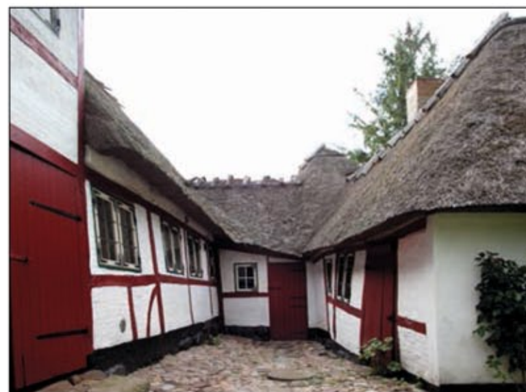
Gårdspladsen ved baghuset.
