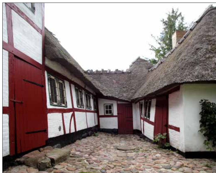
Gårdspladsen ved baghuset
