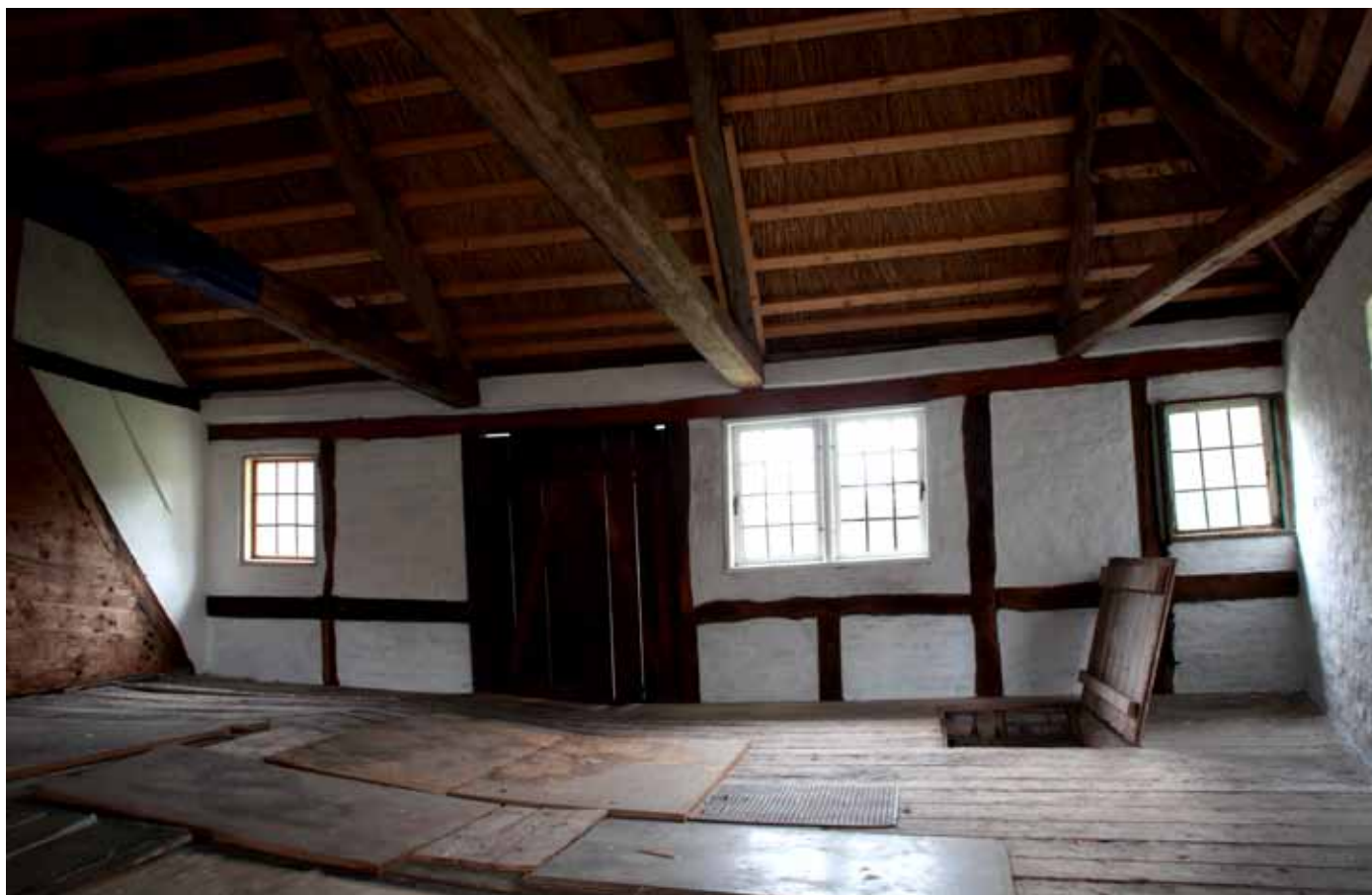
Fra højtømret (overbygningen) ud mod haven med port og trappe ned til vognporten 2022.
