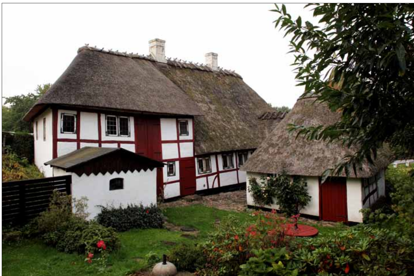
Huset set fra haven, 2022.
