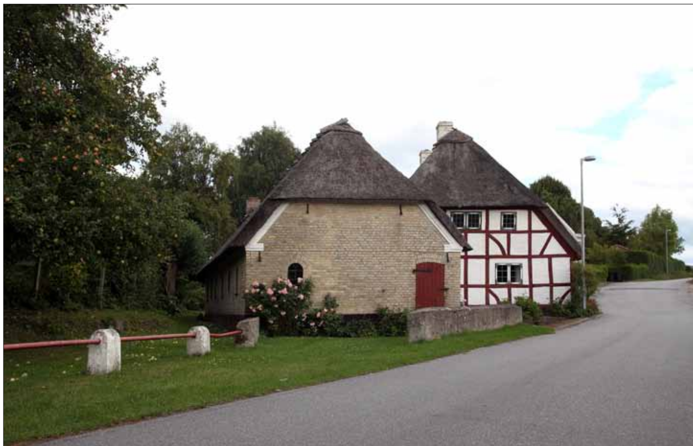
Stalden og hovedhuset set fra gadekæret, 2022.
