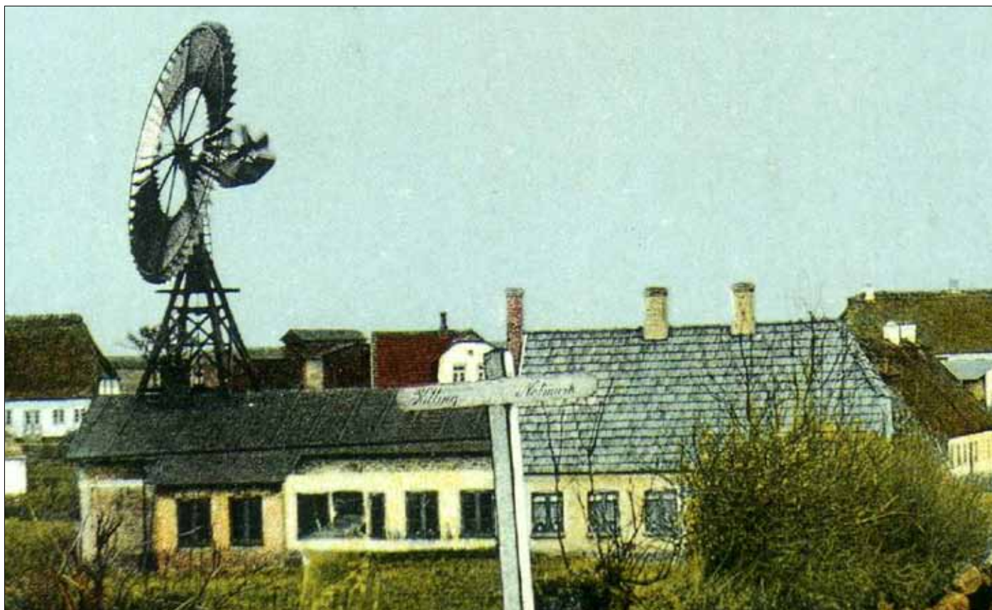
Vindmøllen og savværket blev byggede i 1870erne
