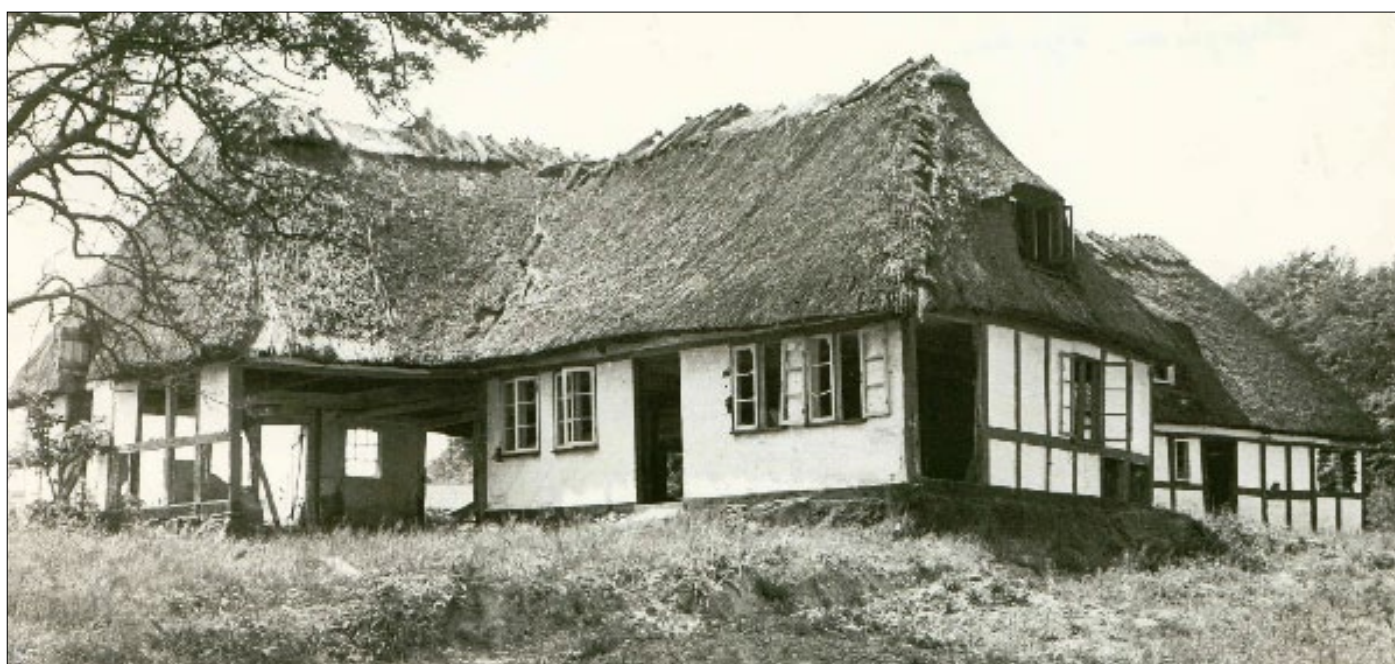
Den gamle færggård før nedbrydning
