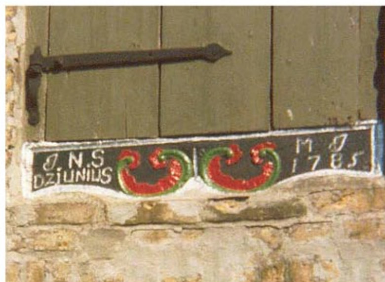
Originale bjælke fra da huset blev bygget.
