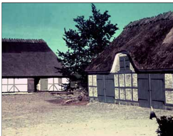
Bladts boel, før ombygning.
