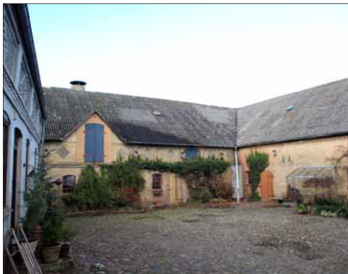
Lade og staldbygningere 2021
