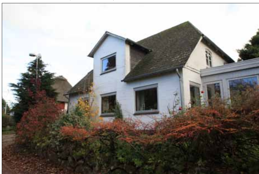
Almsted 35, aftægten. 2021 (Steen Weile)
