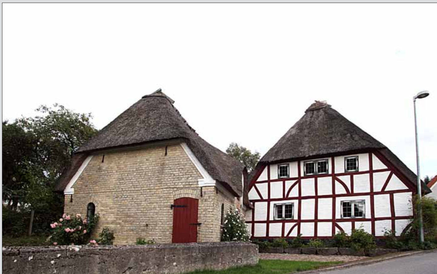
Gavlen af staldbygning samt stuehus set fra vejen
