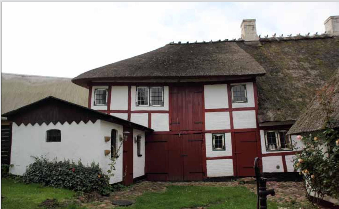
Udhus samt hovedhus med overbygning set bagfra
