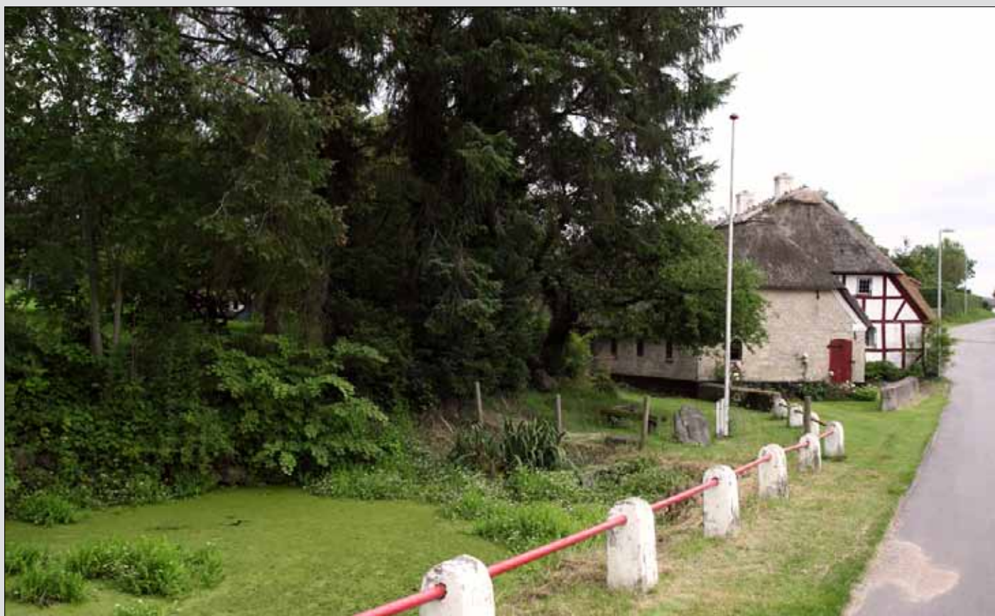
Gavlen af staldbygning samt stuehus set fra gadekæret
