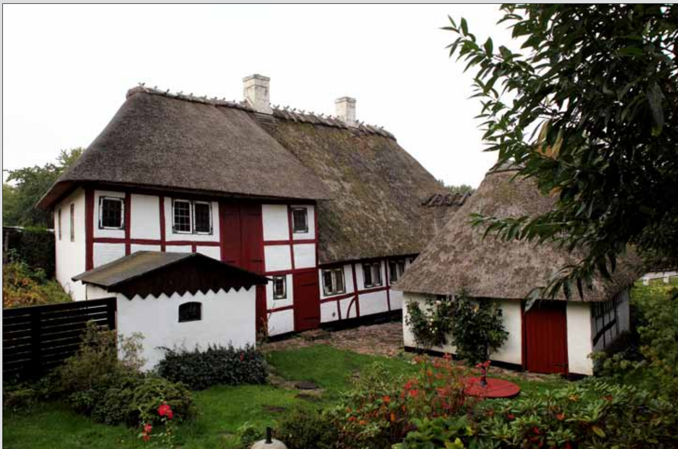
Huset set fra haven
